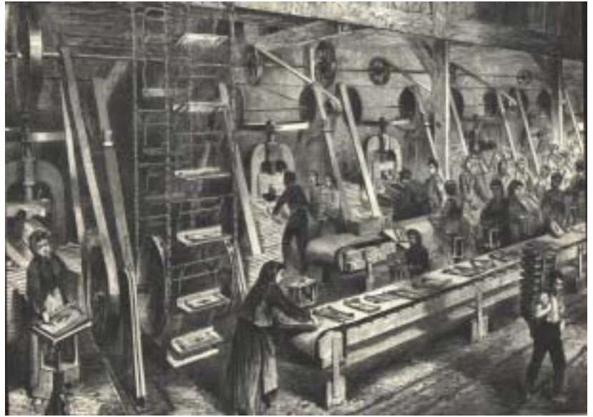
Atelier de fabrication des tuiles à la Grande Tuilerie de Montchanin en 1878
