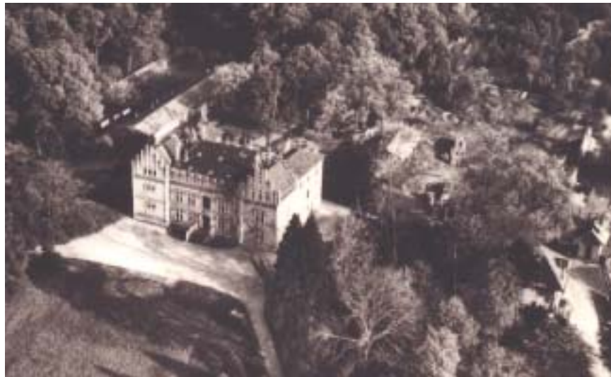
Vue aérienne du château Gilardoni
